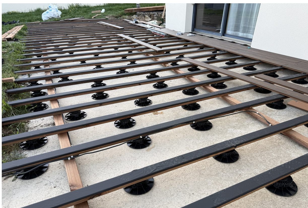
Structure sur plots réglables et lambourdes avant pose complète des lames
