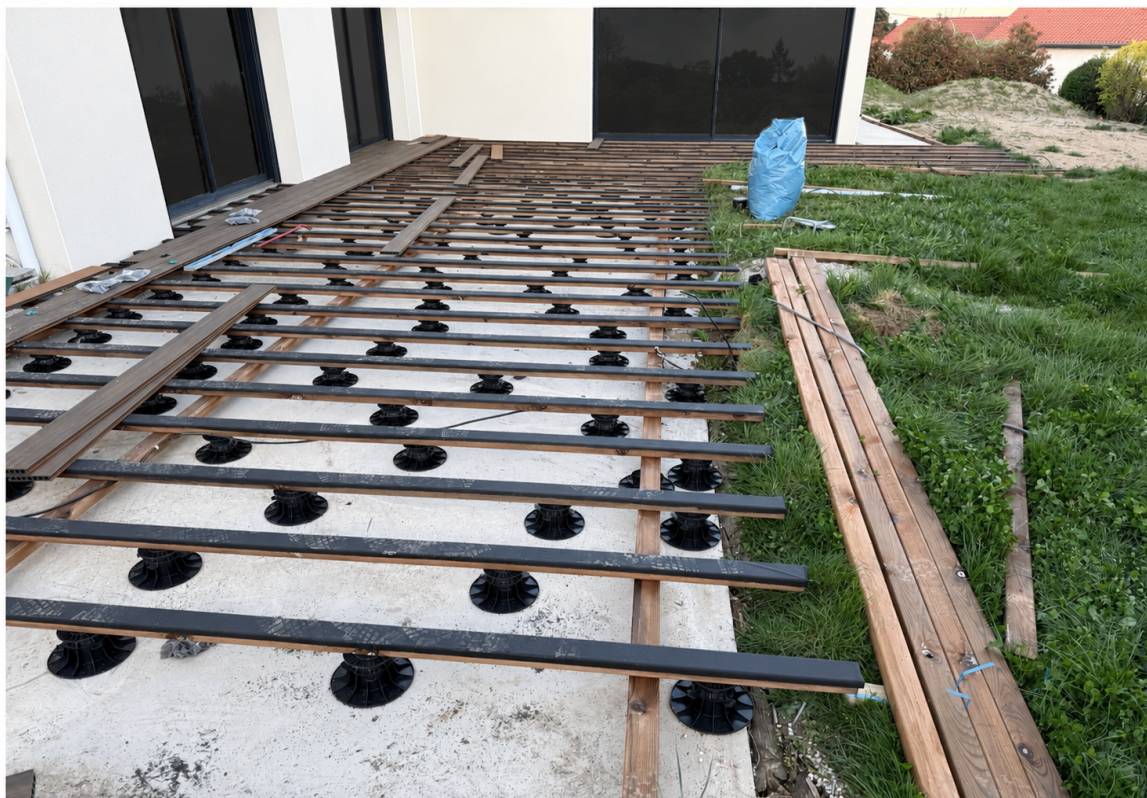
Pose progressive des lames sur l'ossature
